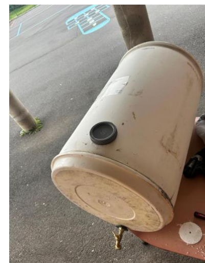
Cuve de récupération d'eau de pluie – Ecole De Gaulle à Vias
