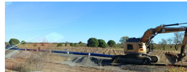
Travaux de raccordement entre Bessan et Vias (Source photo : SMETA)
