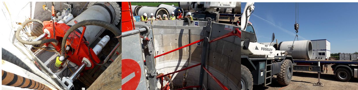
Figure 7 : Visite du chantier en juillet 2021 : passage de la conduite sous le lit du fleuve Hérault
