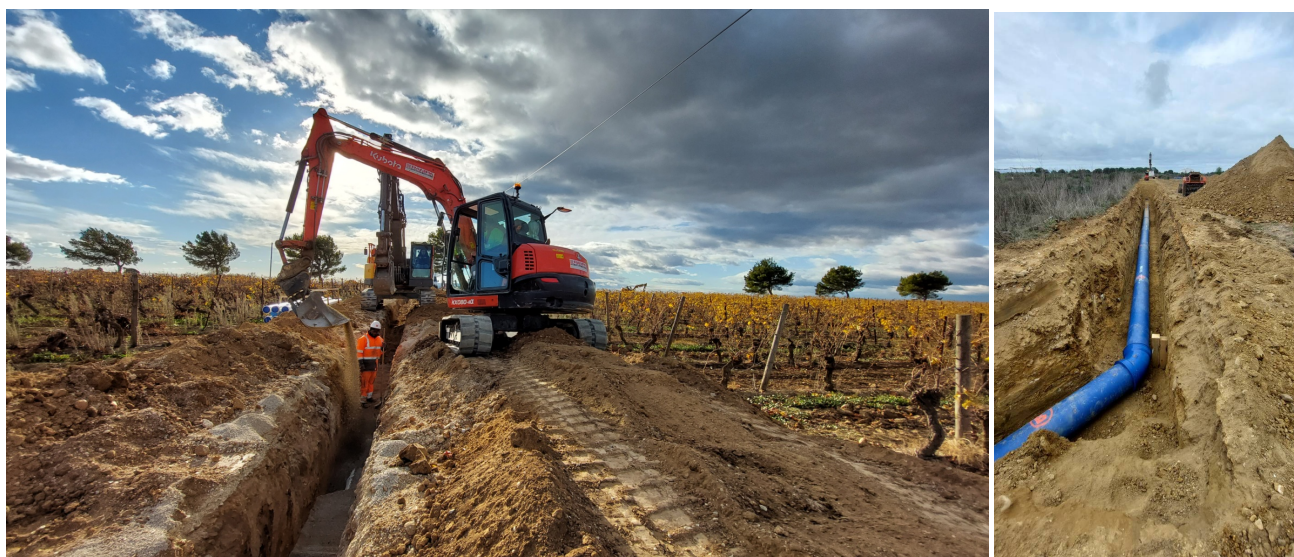
Figure 8 : Pose de canalisations le long des parcelles viticoles (2024)
