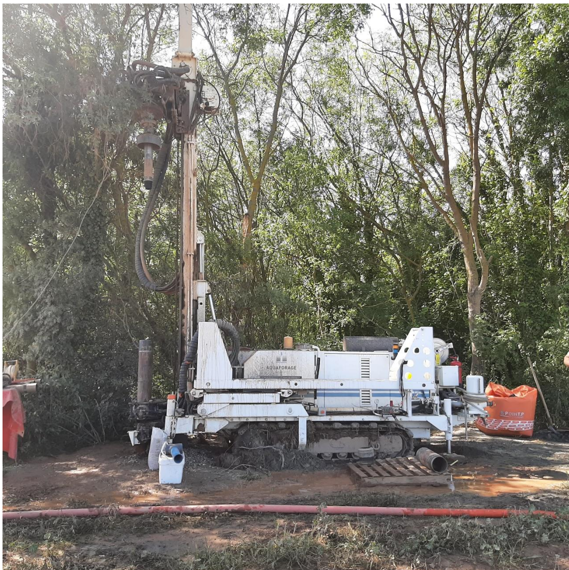
Piézomètre Alluvions – Atelier de foration pour le piézomètre alluvions
