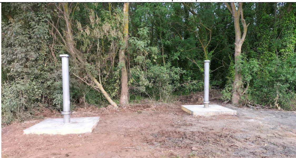
Piézomètre doublet – réhausse des têtes de piézomètres
