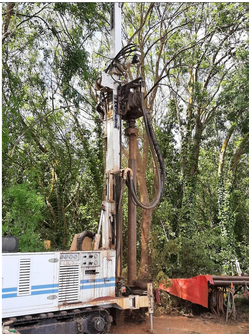
Foration du piézomètre Astien – avancement dans les alluvions
