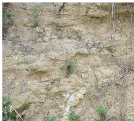
*Figure 6 : Faciès induré des sables observé sur un talus routier*
