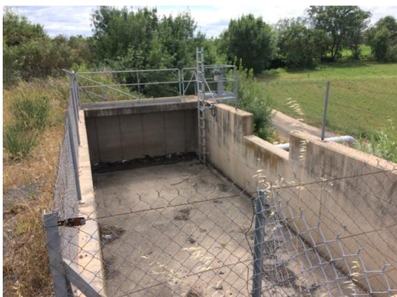
*Figure 31 : Un des bassins de rétention de l'autoroute A9 à hauteur de Florensac sur l'autoroute A9*
