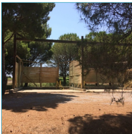
Figure 25 : Aire de remplissage des pulvérisateurs sur la commune de Mèze
