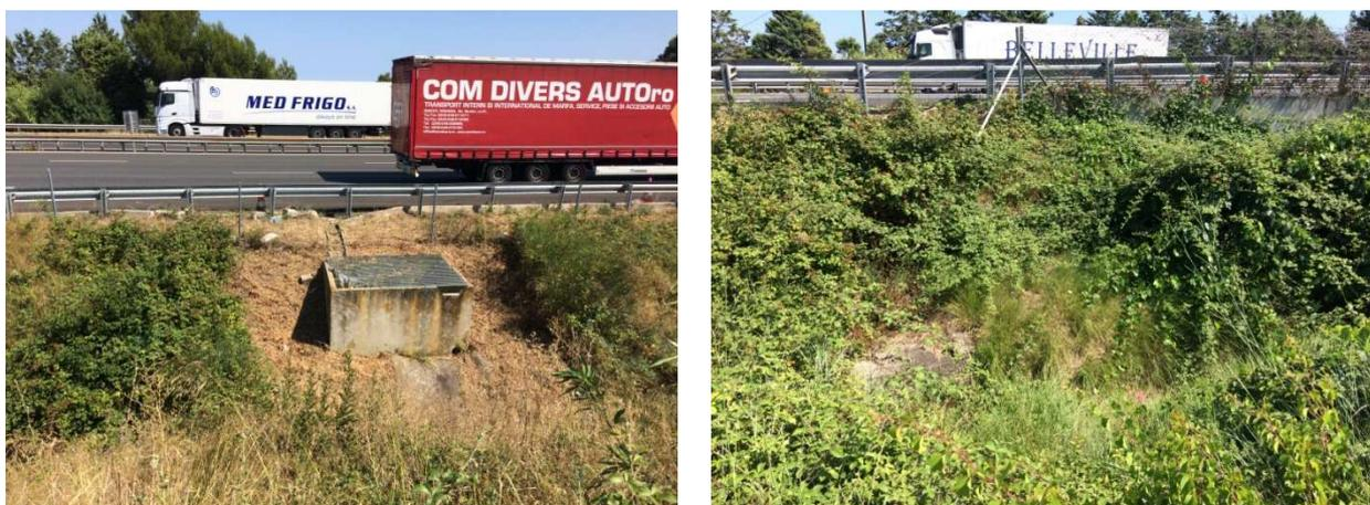
Figure 49 : Ouvrages de gestion des eaux de ruissellement de l'autoroute A9 à Mèze
