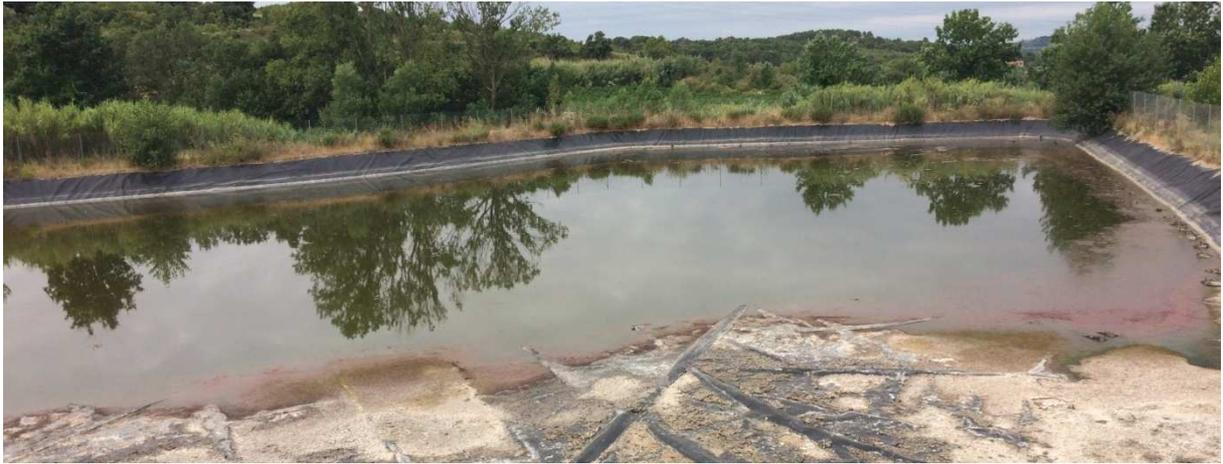
Figure 41 : Bassins d'évaporation de la cave coopérative de Corneilhan (bassin aval avec géomembrane PEHD)
