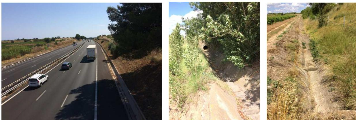
Figure 46 : Dispositifs de collectes des eaux de ruissellement sur l'autoroute A9
