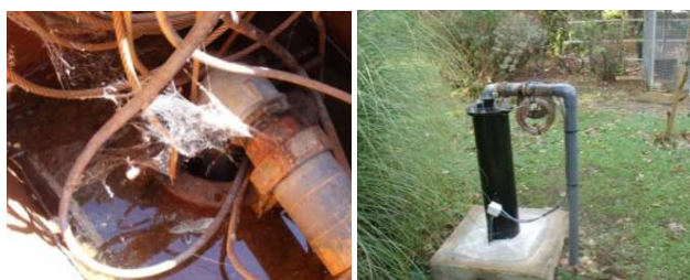
Figure 24 : Réhabilitation d'une tête de forage par le SMETA
